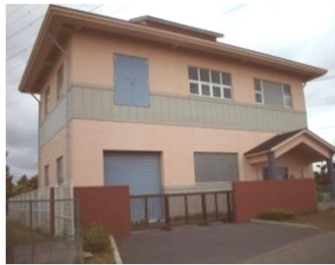
浜田第1汚水 中継ポンプ場
