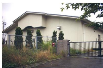
取手汚水中継 ポンプ場
