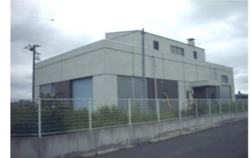
宮和田汚水 中継ポンプ場
