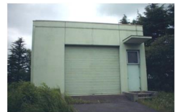
高須汚水中継 ポンプ場
