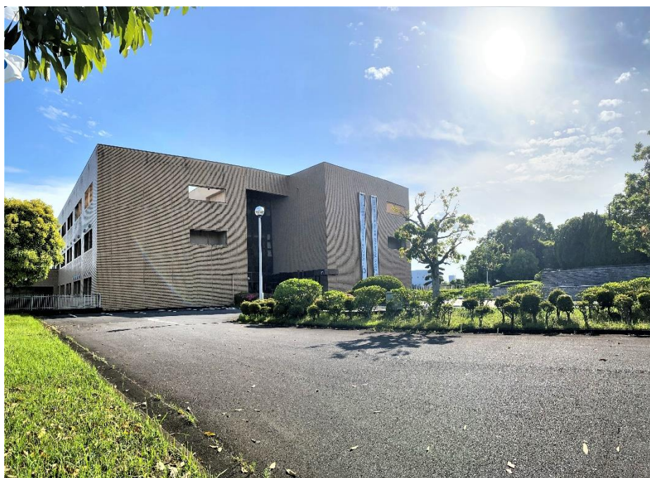
写真1 県南クリーンセンター
