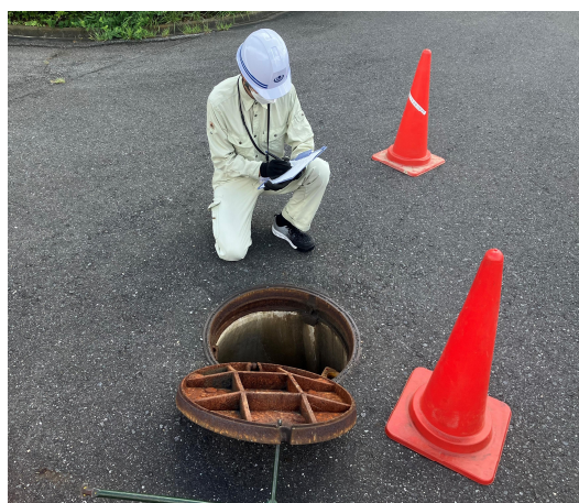
写真 2 管路施設点検作業
